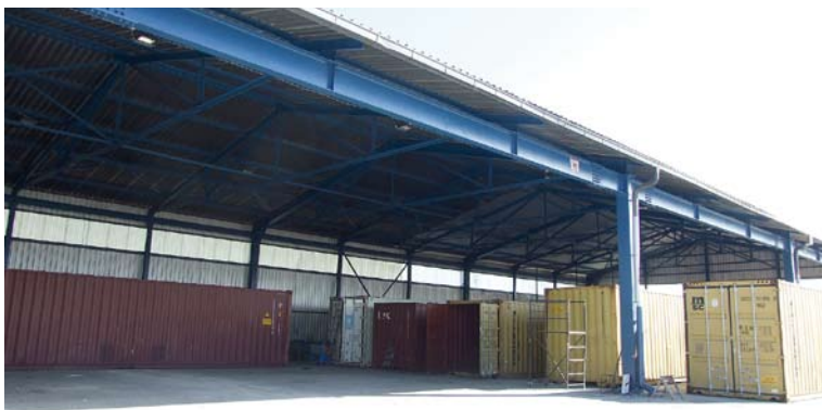
Hala za popravilo kontejnerjev
