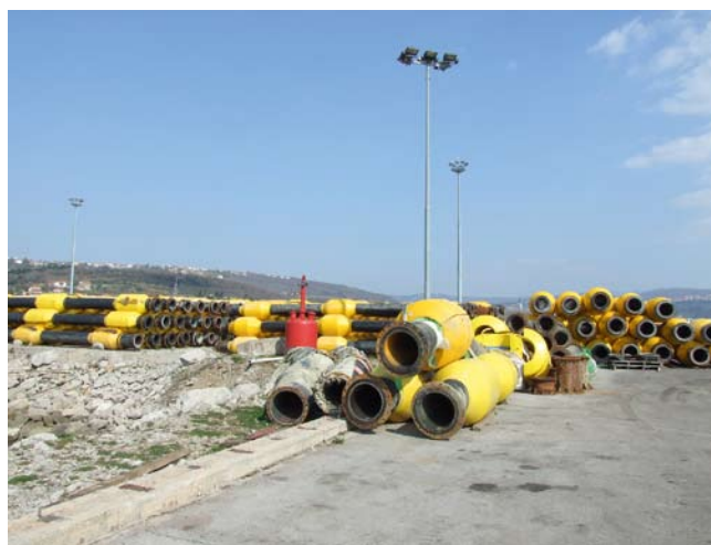
Cevovod so razstavili in vsako cev očistili ter oprali in pospravili na varno mesto na večnamenski terminal
