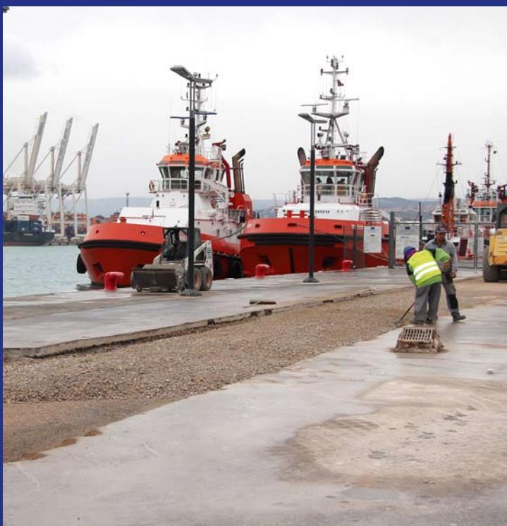
Obala je široka 9 m, sanacijska dela pa potekajo takoj za njo
