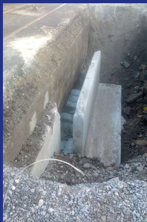
Vgradnja L profilov
