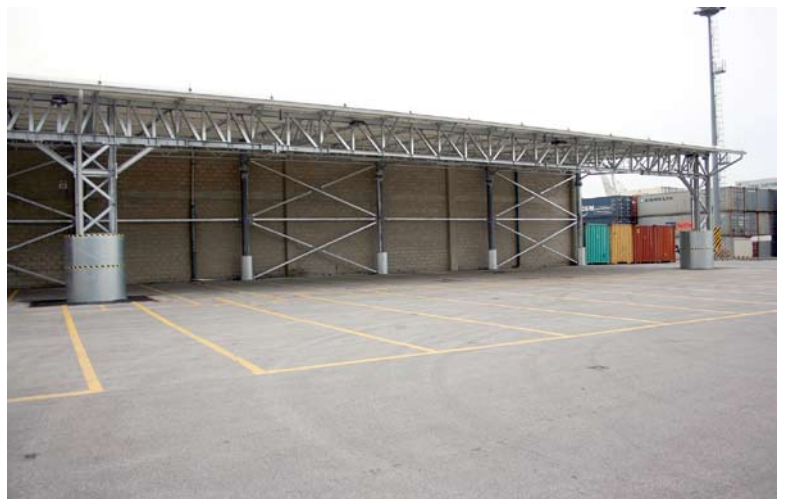
Nadstrešnica nad skladiščem 28 c; stebri so ojačani in zaščiteni pred morebitnimi udari vozil
