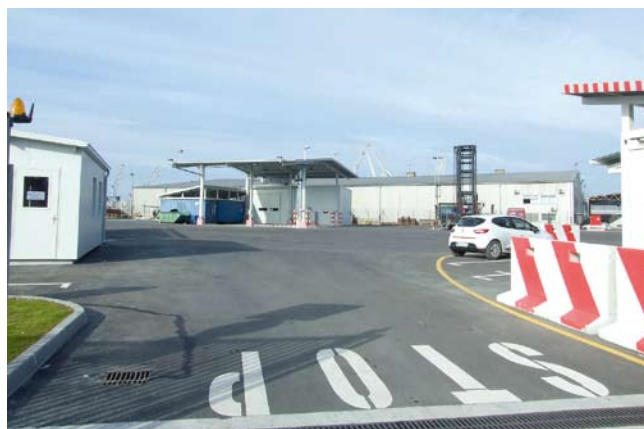
Večja in funkcionalno urejena garaža za kontejnersko mehanizacijo z novimi bivalnimi kontejnerji za osebje garaže
