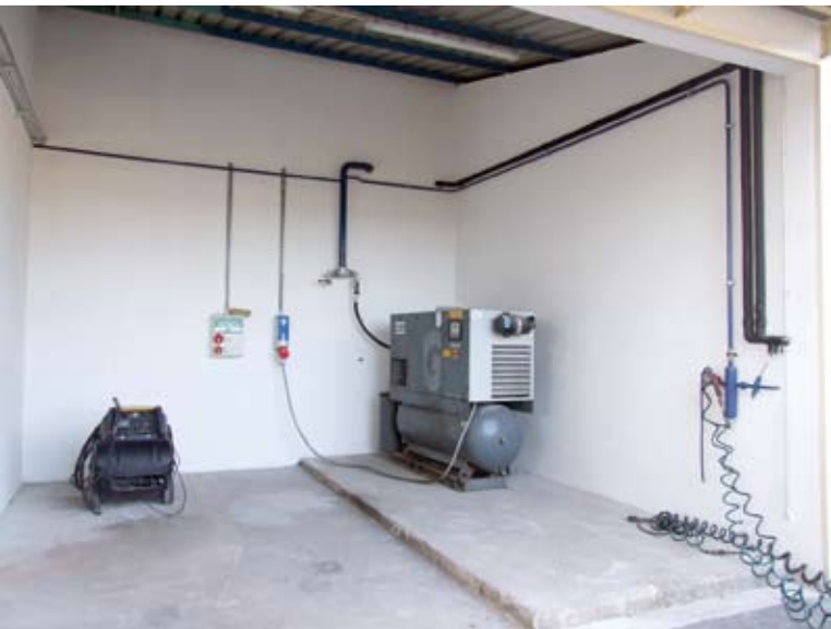
Nova in lično urejena ter pokrita je tudi kompresorska postaja za polnjenje pnevmatik in razna čiščenja na delovnih sredstvih
