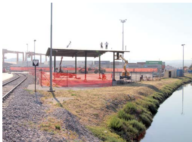
Lokacijo kontejnerske mehanizacije premikamo na območje ob prelivu
