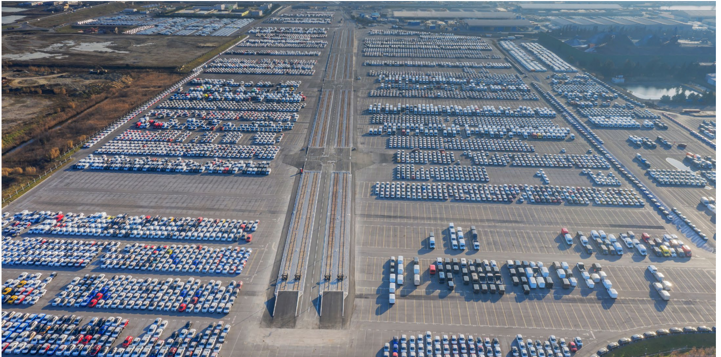
Novozgrajena skupina tirov sega v središče drugega največjega skladišča za vozila.
