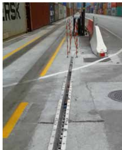
Vgrajeni kanali zmanjšujejo potrebo po priklopu/odklopu dvigal in zmanjšujejo hrup dvigal, ki jih zato ni potrebno tolikokrat zaganjati.
