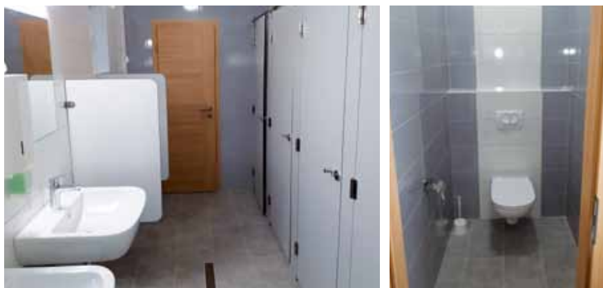
Poleg garderob smo na Terminalu tekočih tovorov obnovili tudi sanitarije v upravni stavbi terminala.
