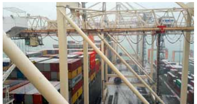
Januarja nas je presenetil sneg, morda bo zima tokrat milejša, kljub vsemu pa sprememb na deloviščih zaradi nizkih temperatur ne gre podcenjevati. Foto: Mehruđin Vuković
