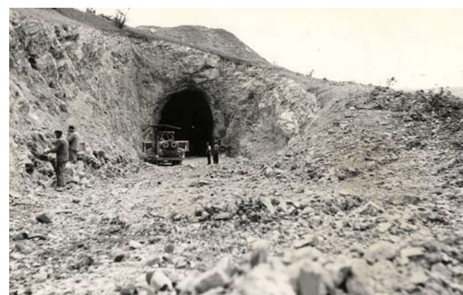
Izgradnja predora Zaniograd, smer Koper
