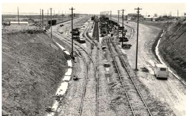
Pogled proti Kopru z nadvoza Koper - Ankaran
