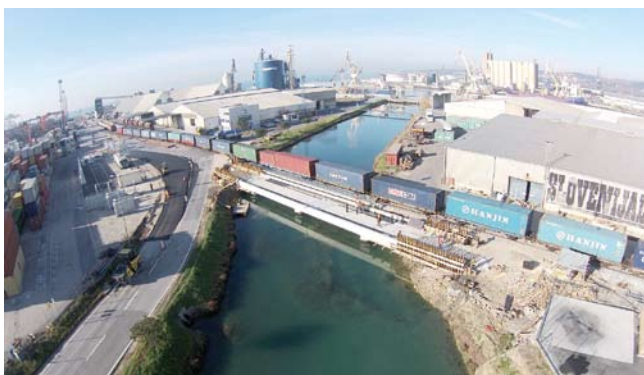
Most čez preliv, preko katerega dostopajo vlaki na kontejnerski terminal Foto: Urban Doltar
