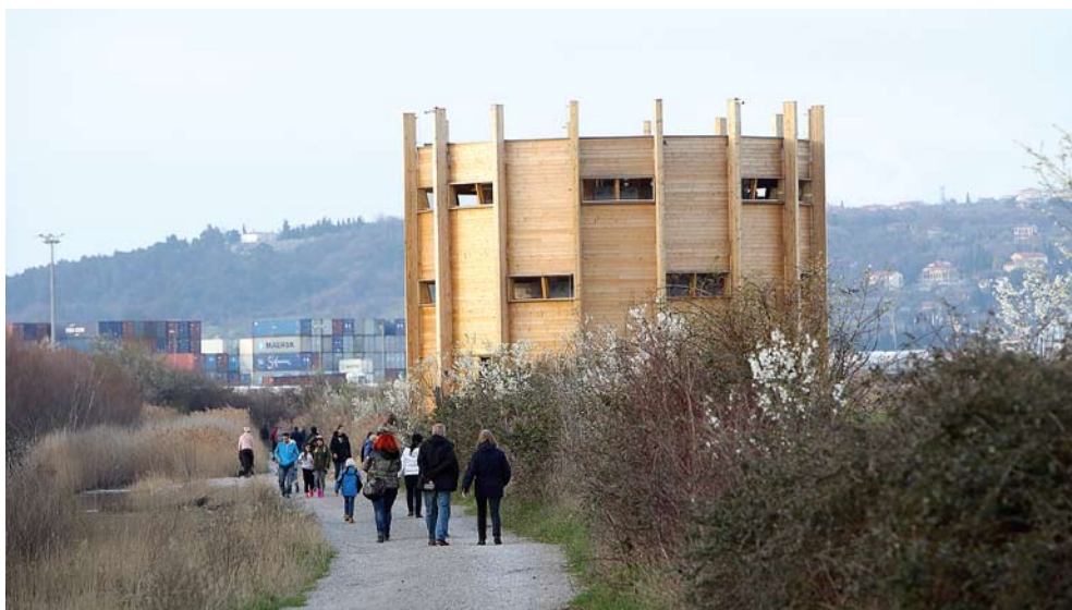
12 metrov visok osrednji opazovalni stolp, s katerega je prelep razgled na laguno in močvirje, je ena najlepših in najbogatejših pridobitev prenove
