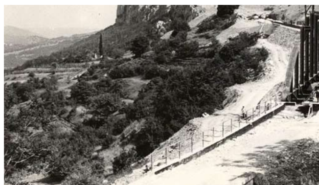
Postavljanje mosta z opuščene planiške proge pri Martuljku so uporabili za premostitev plazu v Podpeči
