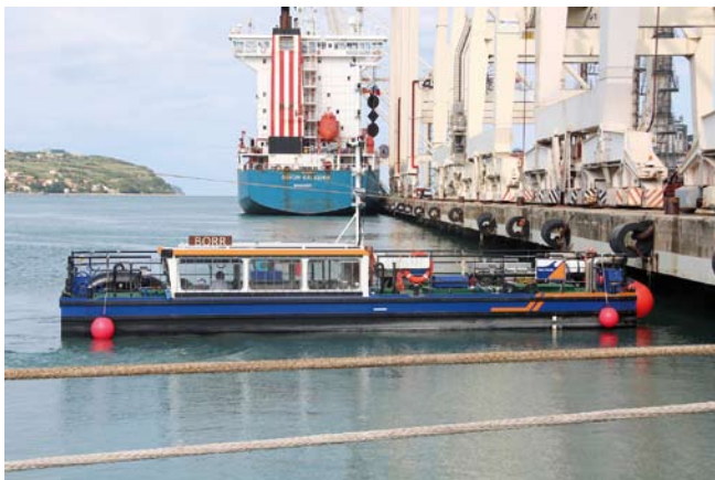
Borr je poglabljal pod konstrukcijo kontejnerske obale
