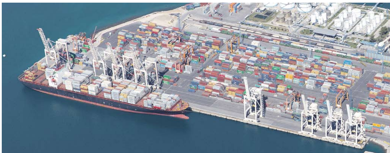
Danes imamo na obali osem kontejnerskih dvigal, in sicer štiri panamax in štiri post panamax dvigala
