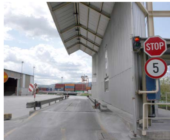
Kamionska tehtnica na območju terminala za sipke tovore
