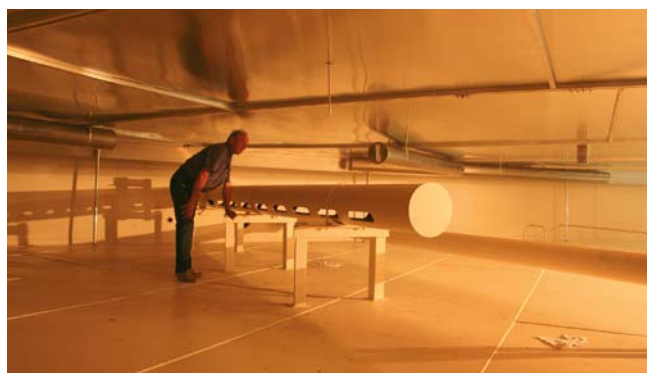
Dno rezervoarja s plavajočo pokrovnico, ki je bila v času gradnje še pritrjena na jeklenice. Jadranko Mahnič stoji ob glavni dovodni cevi, skozi katero priteče tovar z ladje.
