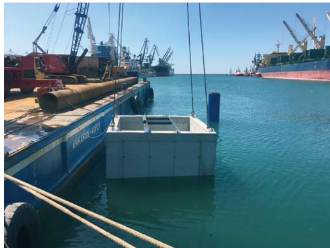
Izkopu morskega dna je sledila postavitve škatle (Slika 1)
