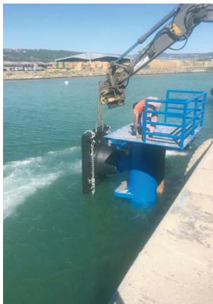
Na jekleno cev so montirali gumijasti odbojnik (Slika 3)
