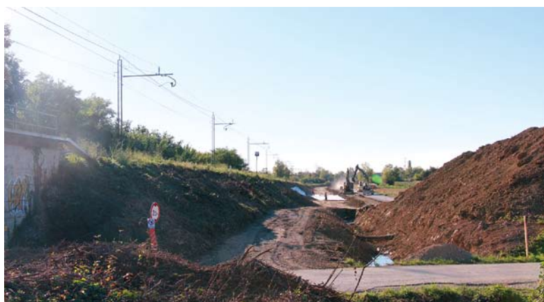
Gradbišče izvlečnega tira
