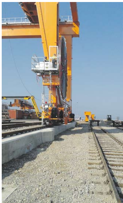
Dvigalo RMG je že postavljen na žerjavni progi
