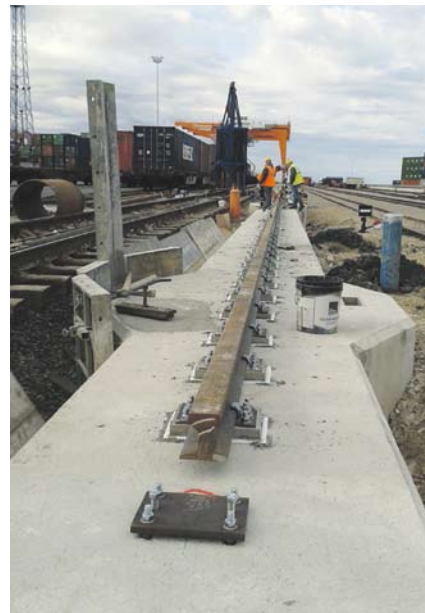
Montaža tirnice na betonsko gredo
