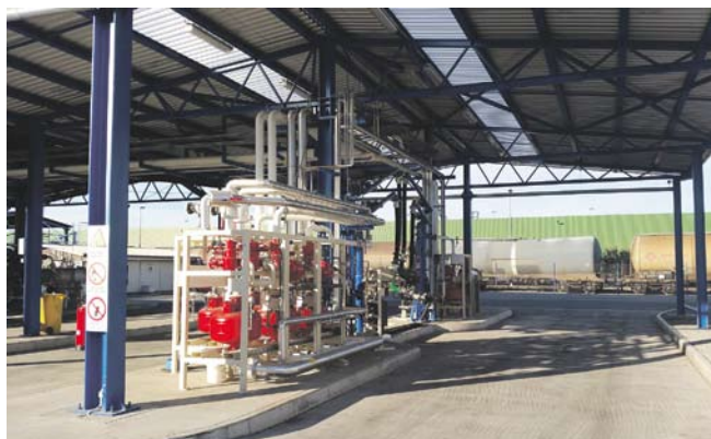
Polnilnica je opremljena z merilnimi linijami in pretakalnimi rokami za spodnje polnjenje, ki so nameščene tako, da lahko oskrbujejo obe strani otoka
