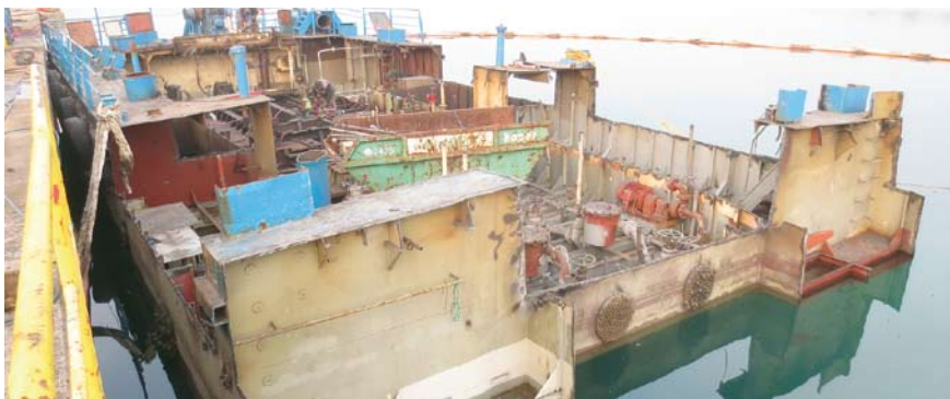
Nazadnje so ostanek lupine dvignili na obalo, ga do konca razrezali in vse odpeljali
