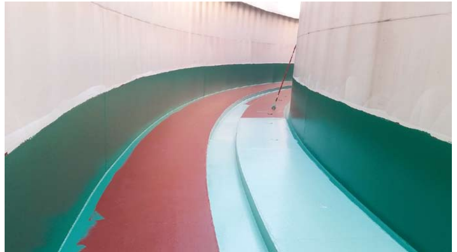
Na temeljni rdeči premaz so nanesti še dva zelena, vmesnega in gornjega v dveh različnih niansah, tako je bilo videti, da je izvajalec nanesel premaz zadostne debeline, kar so na koncu tudi izmerili
