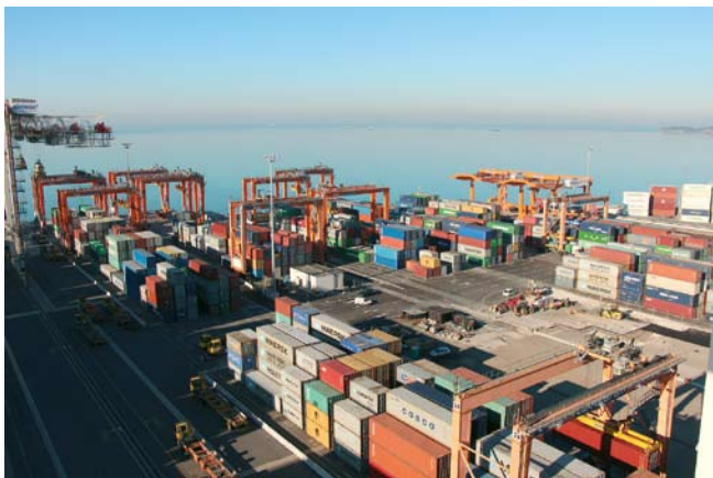
Na kontejnerskem terminalu smo skozi celotno leto 2016 izvajali temeljito rekonstrukcijo terminala. Utrjevali smo površine, urejali vodovodno, komunalno, elektroenergetsko, telekomunikacijsko infrastrukturo in izvedli številne druge naložbe, pri tem pa ni smelo trpeti vsakdanje operativno delo.
