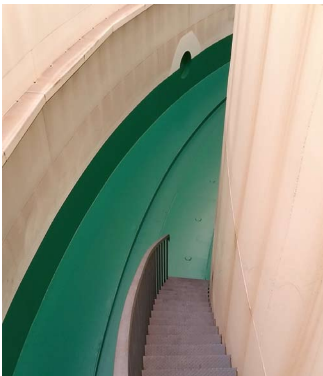
Rezervoar po zaključeni sanaciji
