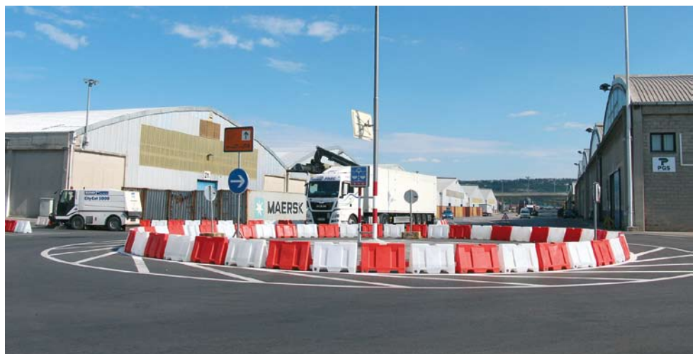
Montažno krožišče na luški vpadnici zmanjšuje hitrost in povečuje prometno varnost.
