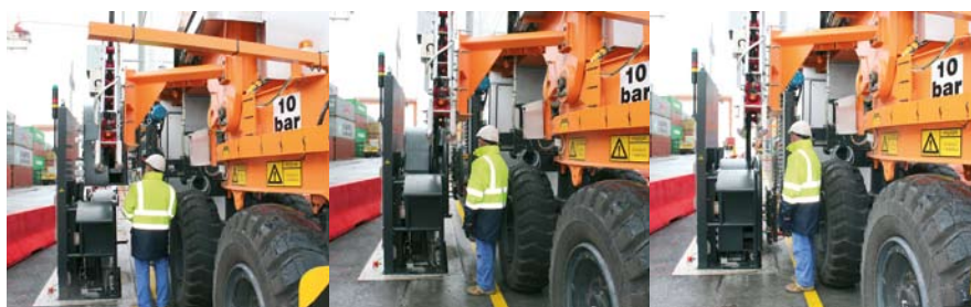
Bili smo priča prvemu testnemu priklopu dvigala na »vtičnico« (črna naprava na levi). Sicer je sistem priklopa dvigala na priklonno mesto prava novost. APS sistem (Automatic Plugin System) namreč omogoča avtomatski priklon na električno omrežje in istočasen izklop dizelskih agregatov. Ko senzorji na dvigalu zaznajo območje priklonnega mesta, upravljavec dvigala sproži postopek samodejnega priklopa na električno omrežje.
