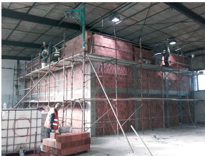
Predelne stene z zidaki iz morskih sedimentov
