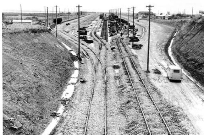
Gradnja železniške tovarne postaje na Srminu
