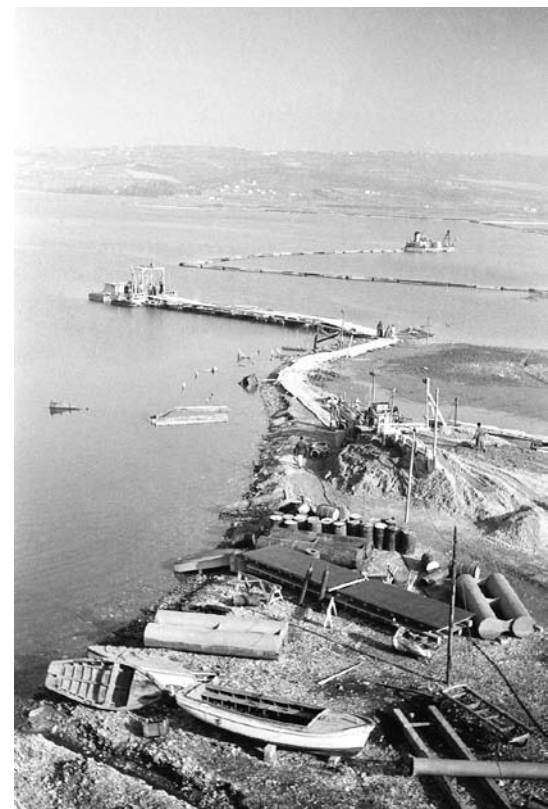
Zasipavanje in priprava terena za gradnjo nove obale proti vzhodu
