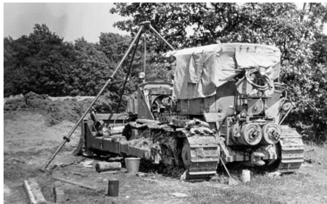
S takšnimi buldožerji so gradili pristanišče; to so bili odlični stroji, znamke Challenger, ki so tehtali po 20 ton.
