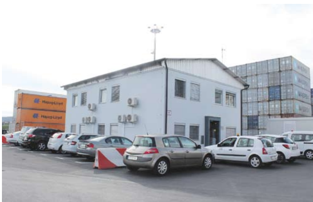
V bivšem objektu terminala za les, ki služi kot upravna stavba depoja, so zamenjali pohištvo in obnovili celotno opremo prostorov, elektro instalacije ter požarni sistem. V pritličju so povečali garderobe in uredili sanitarije s tuši. Skupna površina preureditve je 239 m 2 . Projekt prenove je vodila Bojana Kavrečič iz Področja investicij, izvajalec del je bil IGC Projekt.
