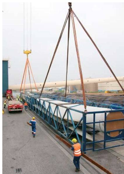
Ohišje, v katerem so spravljene tri lopatice je dolgo 45 metrov in težko 38 ton.
