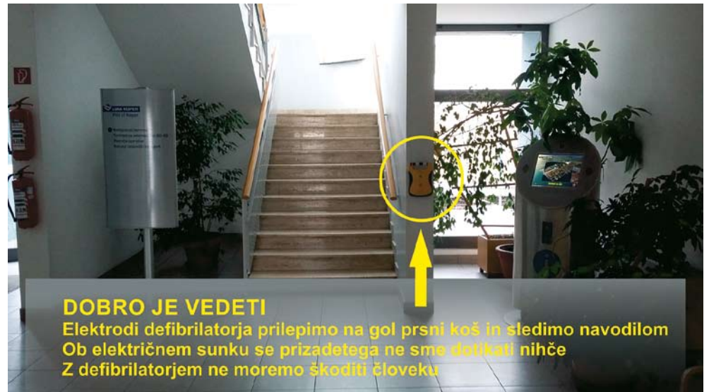
Zadnje nameščeni AED je lociran v spodnjem hodniku upravne stavbe Kontejnerskega terminala.
