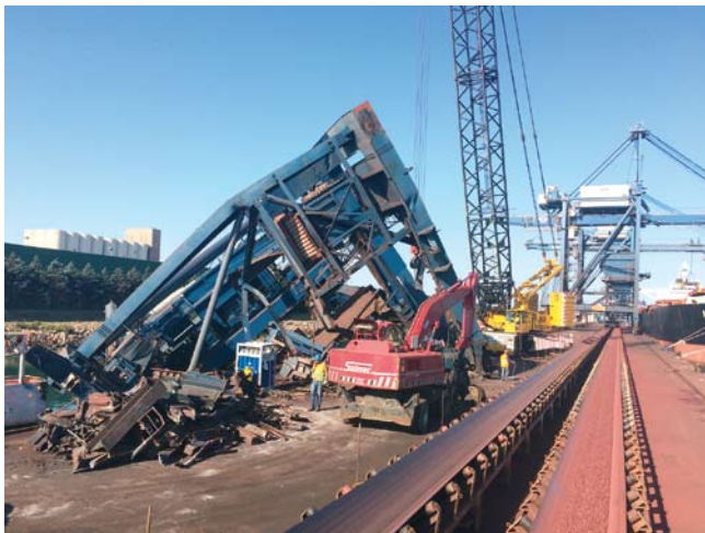
Končni razrez so opravili na obali, razrezane dele pa odvažali kot staro železo v jeklaro.
