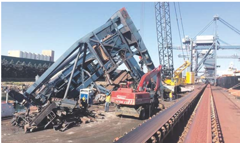
Dokončno slovo obalnega dvigala MD1 na EET
