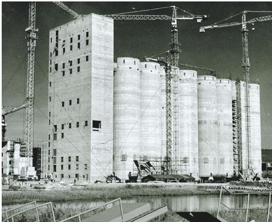
Silos sestavlja 24 celic višine 45 metrov in z 12 medceličnimi prostori premore kar 60 tisoč ton skladiščne kapacitete.
