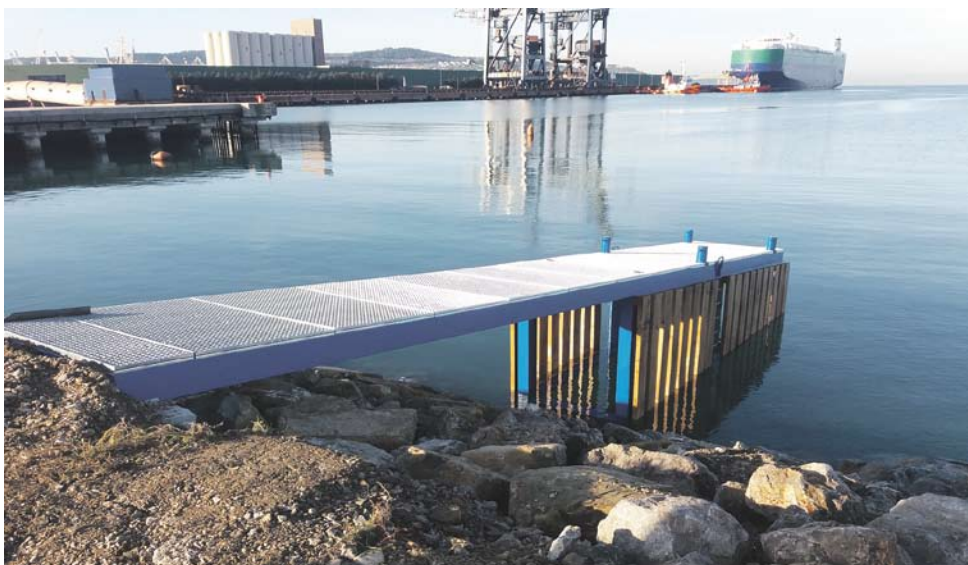
Severno od obstoječega priveznega mesta VNT je bil za potrebe privezovalcev zgrajen nov dostopni mostiček, s katerega bodo ti lahko varno prenašali vrvi z ladje do privezne bitve na obali.
