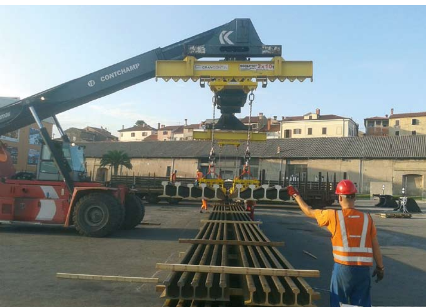
Pri razkladanju posamičnih tirnic z vagonov s pomočjo distančne plošče razdvojimo tirnice v sklope po pet. Po zaključenem vezanju tirnic z distančno ploščo spet sestavimo sklope po deset tirnic, ki so pripravljene za nakladanje na ladje.
