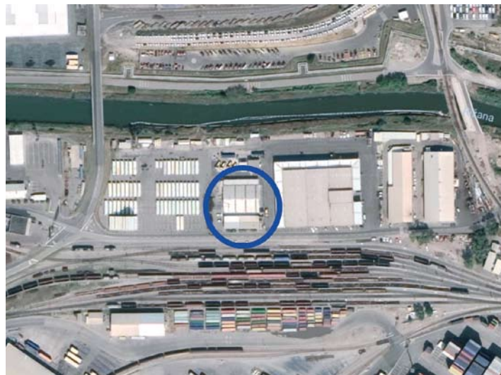
Objekt, ki mu s pridihom nostalgije še vedno rečemo hala Troples, se nahaja pred cestnim mostom čez Rižano na desni.
