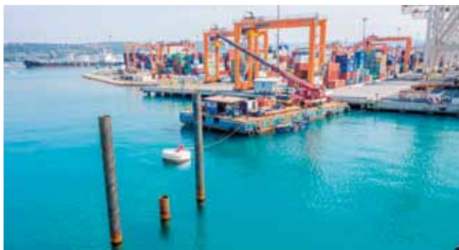
Takole smo v objektiv ujeli prve testne pilote, ki bodo nosili zadnji podaljšek pomola. Foto: Kristjan Stojaković
