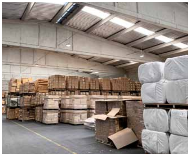
V okviru pilotne akcije TalkNET so bila v skladišču zamenjana metal halogena svetila z varčnimi LED svetili. Skoraj polovico investicije je pokril sklad ERDF v okviru projekta TalkNET, program Srednja Evropa. Foto: Goran Matešić
