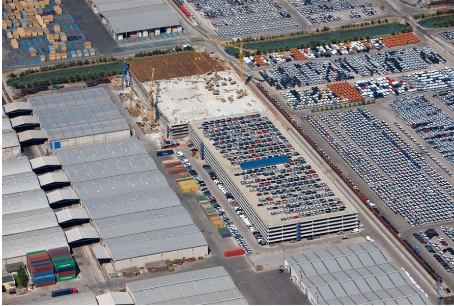
Slika 1: Gradnja skladiščnega objekta za avtomobile
