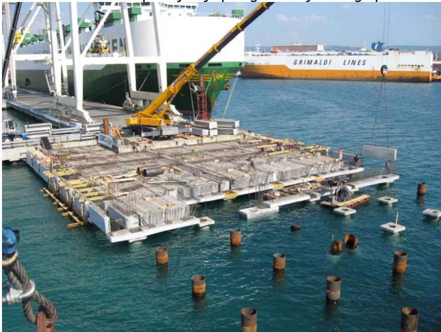
Slika 2: Gradbišče za podaljšanje prvega kontejnerskega pomola
