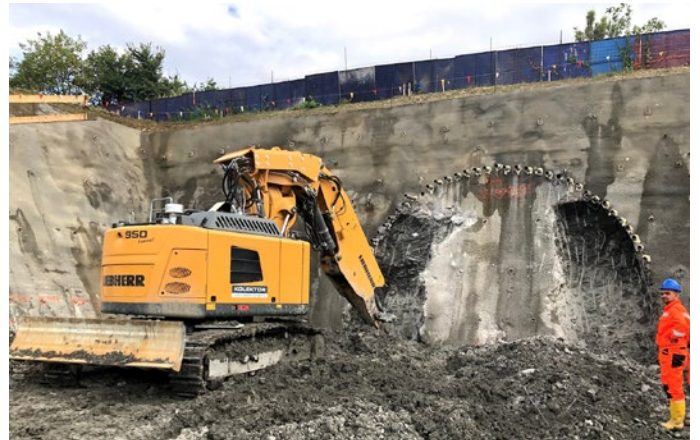
Prvo kopanje tunelov na trasi 2. tira se je pričelo v Dekanih in nad Osapsko dolino.
