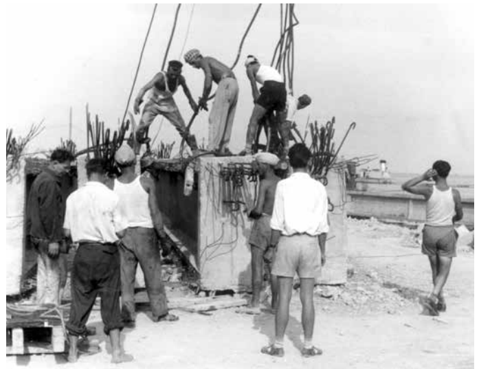
Delavci so vlagali veliko napora in truda v gradnjo pristanišča.
