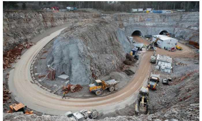
Prvih 1.000 »predorskih« metrov na trasi drugega tira so izkopali v predorih Škofije, Mlinarji in Lokev.
