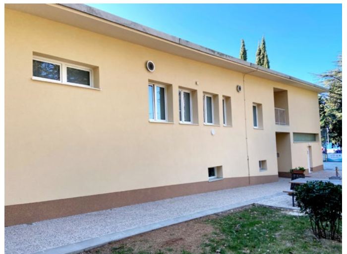
... in po obnovi.
